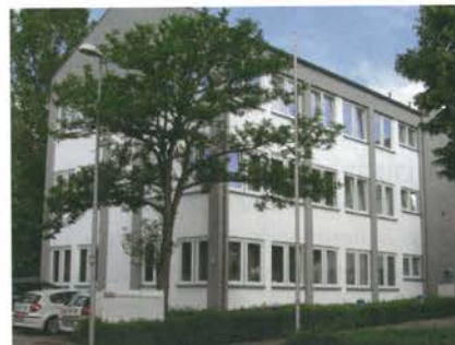
Die neue Niederlassung Rhein-Main der Simba Computer Systeme GmbH in Mainz-Hechtsheim
